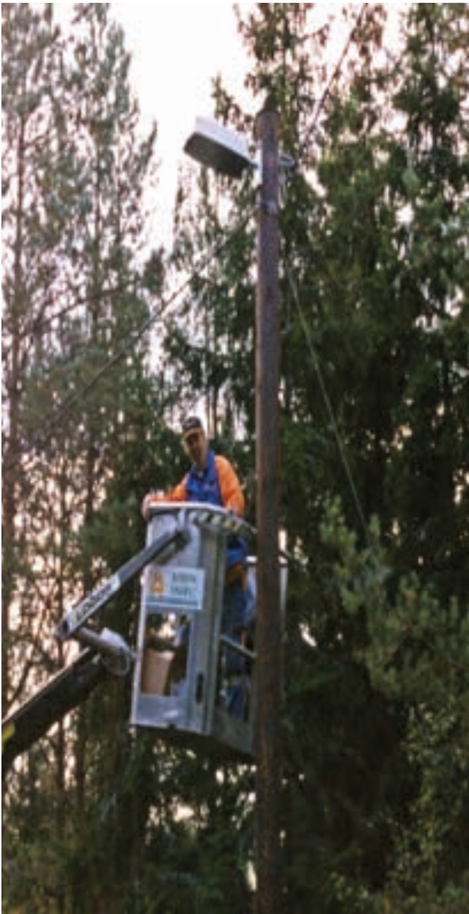
Rodhen Energi monterar nytt elljus 1997.
