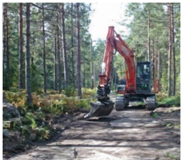
Grovplanering har startat med en grävmaskin i spåret.
