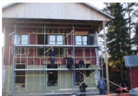
Isolering av lokalen.
