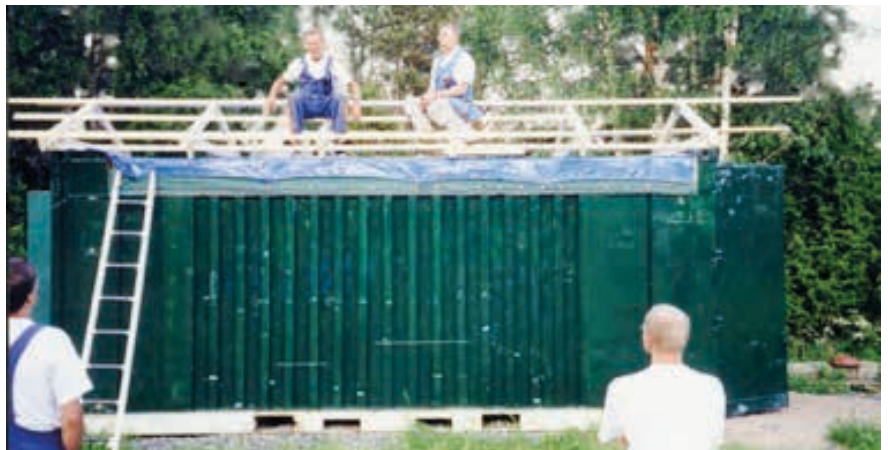
Sektionsstyrelsen lägger tak på garaget under ledning av ordförande Hans Ahlström.
