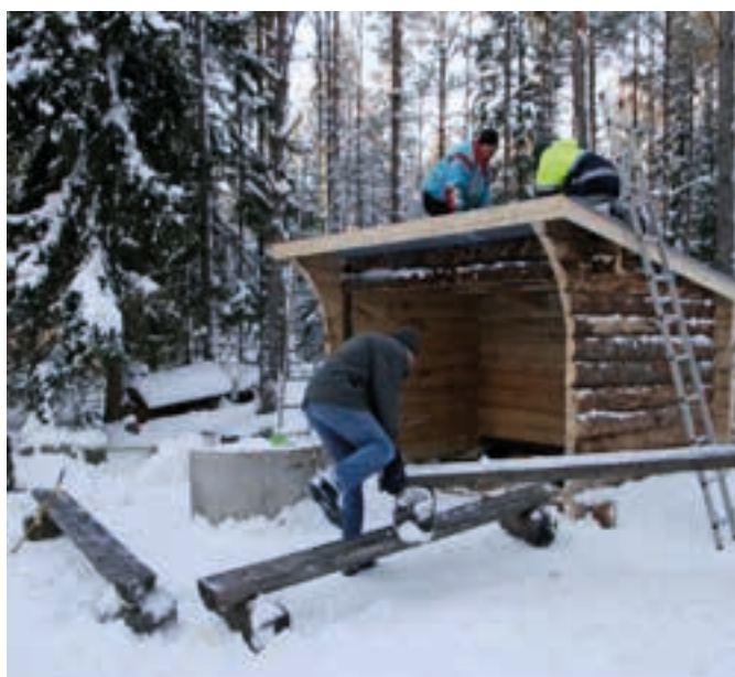
Skidsektionen bygger en mullekoja 2010.
